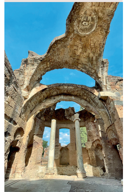
Sopra e nella pagina a fianco, Villa Adriana; in alto, Villa d'Este
